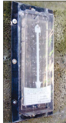
Mit Schlagdübel befestigte Kunststoffabdeckung
