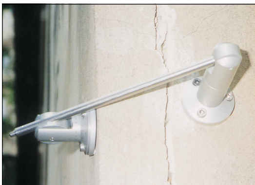
Analyse des Verlaufes eines Risses an der Fensterleibung, auf der Ebene der Armaturen
